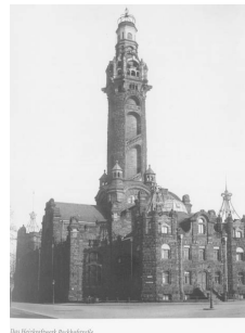
Das Heizkraftwerk Dresden-Mitte
