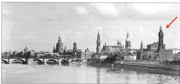
Dresdens weltberühmte Silhouette, in die sich der Schornstein-Turm des Fernheiz- und Elektrizitätswerkes einfügte
